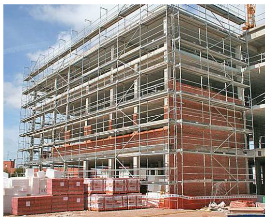
Andamio de construcción.
